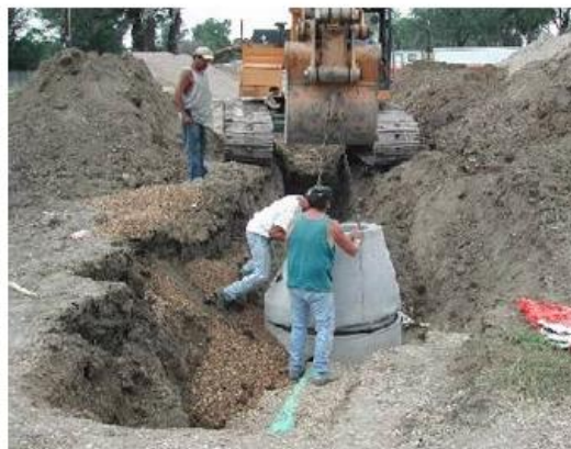
Montaža armiranobetonskog okna
