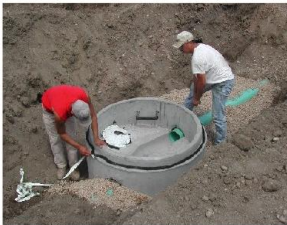
Montaža armiranobetonskog okna
